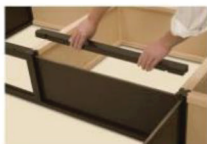
(4) 上枠の取付け
