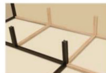
(2) 柱と下枠の組立て
